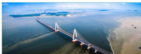
我系主持的乐清湾2号跨海特大桥施工控制测量
